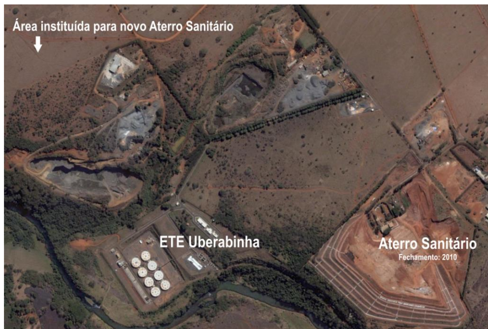
Foto 12: Vista Aérea do Aterro Sanitário
